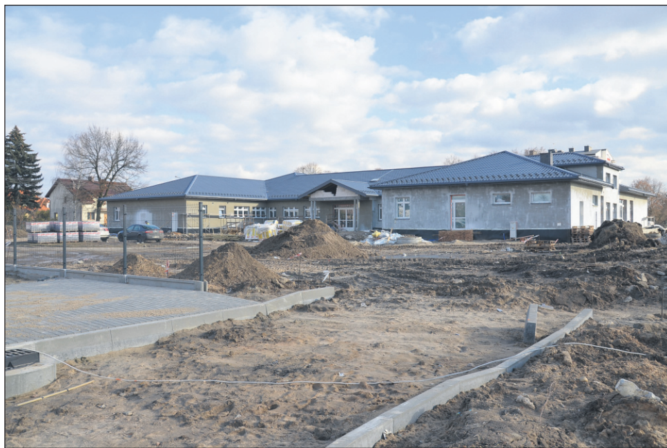
Do czerwca mają zakończyć się prace związane z budową nowej siedziby Przedszkola nr 3 (fot. J.P.)
